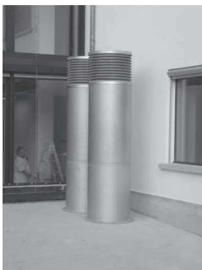
Säulen-Lamellenhut mls Standrohr längsgeschweisst mit Befestigungsflansch Aussen-/Fortluft
