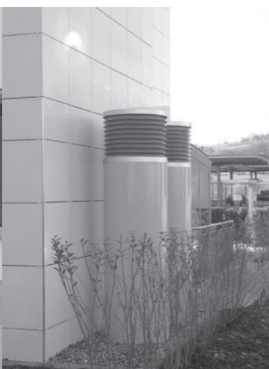
Lamellenhut mls Standrohr längsgeschweisst mit Befestigungsflansch Aussenluft
